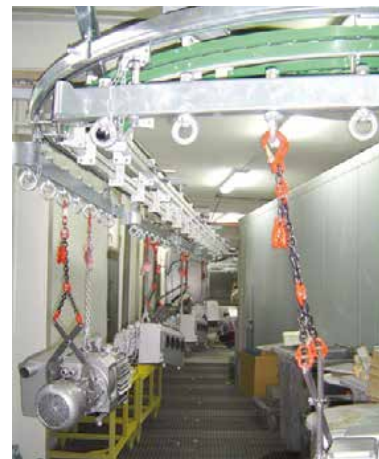
Système à monorail aérien couplé à un convoyeur aérien permettant de transporter des pompes à vides à travers un séchoir
