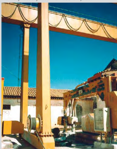
Pružinový kabelový buben na mostovém jeřábu
