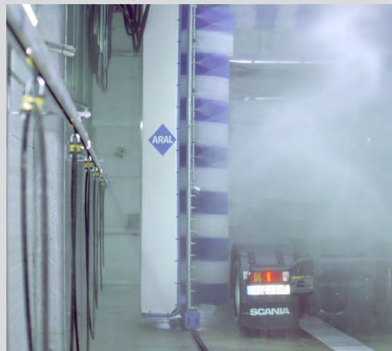
Kabelová vlečka ve vlhkém prostředí
