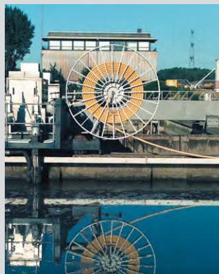
Motorový navijecí buben v čistírně odpadních vod
